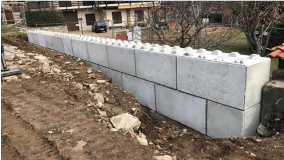
Figura 4 – Esempio di installazione di blocchi di calcestruzzo prefabbricati
